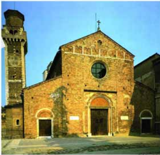
Prospetto della Basilica dei santi Felice e Fortunato
